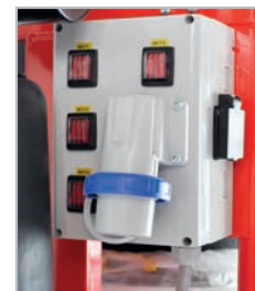
Monofásico con 3 motores más 1 motor con agitador de filtro
